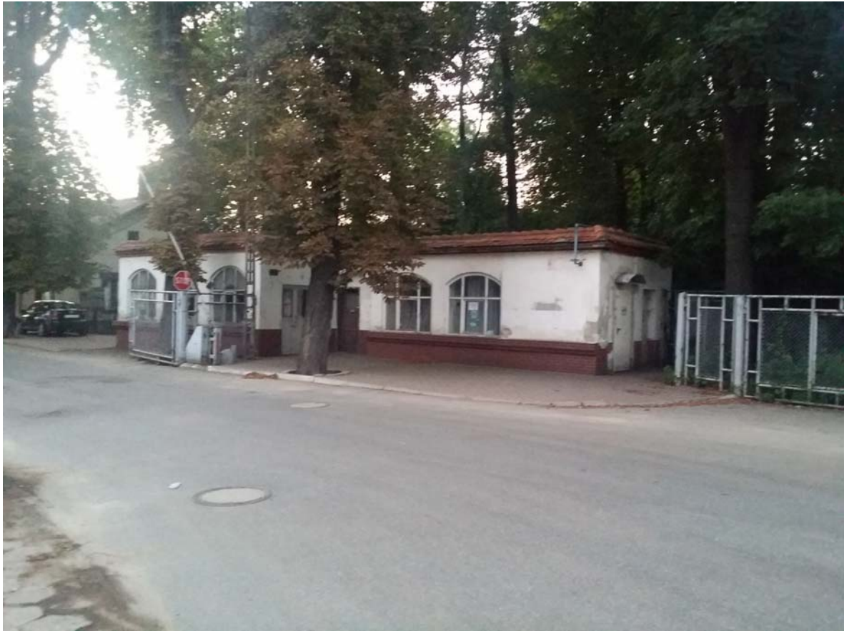
obiekt nr 6. Biuro przepustek
