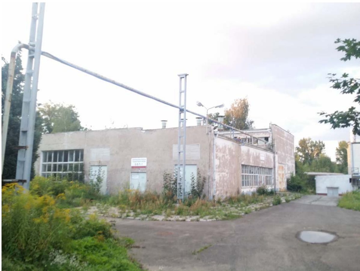
obiekt nr 114. Kompresorownia
